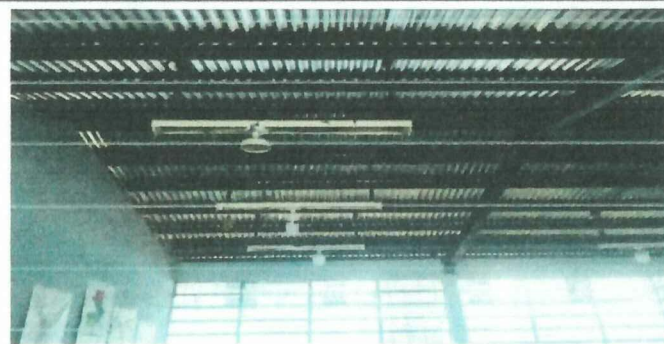
Foto 10: luminarias de las aulas, sustitucion de cableado por nueva instalacion de plafoneras, tomacorrientes y apagadores.
