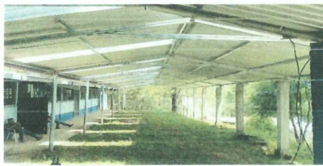
Foto 12: instalacion nueva, de luninarias en corredor salon de eventos, instalacion de plafoneras, y apagadores.
