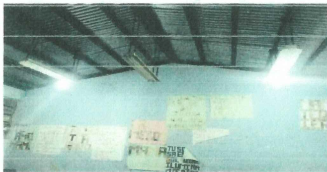
Foto 9: luminarias de las aulas, sustitucion de cableado por nueva instalacion de plafoneras, tomacorrientes y apagadores.
