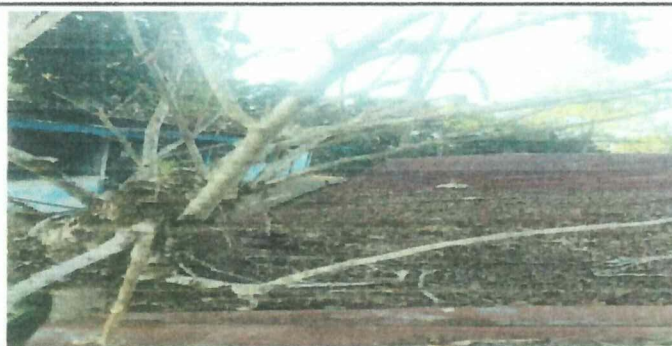
Foto 5: INSTALACION Y CAMBIO DE LAMINAS ACANALADAS POR LAMINAS TROQUELADAS CALIBRE 26.
