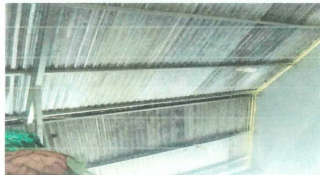
Foto 8: luminarias de las aulas, sustitucion de cableado por nueva instalacion de plafoneras, tomacorrientes y apagadores.
