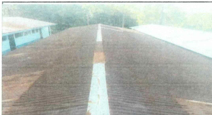
Foto 4: CAMBIO DE TECHO MODULO INSTALACION Y CAMBIO DE LAMINAS ACANALADAS POR LAMINAS TROQUELADAS CALIBRE 26. Y CAPOTES LISO CALIBRE 26
