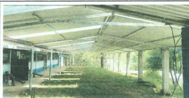
Foto 6: insalacion de canales, bajada y fabricacion de pescantes lado derecho
